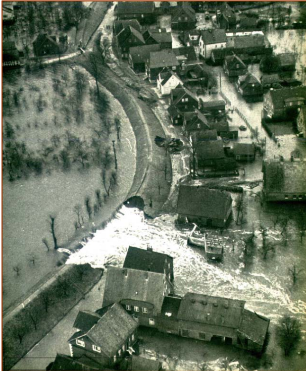
Der Neuenfelder Deich brach an mehreren Stellen
