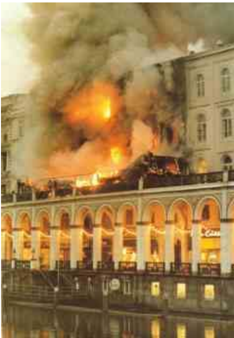
Das Restaurant über den Alsterarkaden brennt in voller Ausdehnung mit Brandausbreitung in das 2. und 3. Obergeschoß
