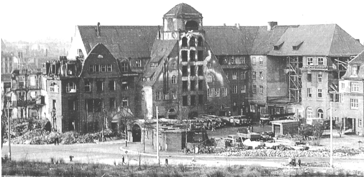
Die Hauptfeuerwache am Berliner Tor bei Kriegsende wie ein Fels aufragend im zerstörten St. Georg
